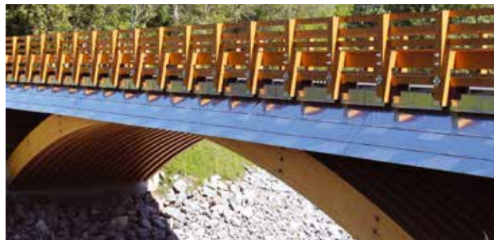
Pont Bishop à Portneuf — le bois peut être utilisé pour une grande variété de constructions. Pour un maximum de durabilité, la structure doit dévier l'eau, permettre l'évacuation de l'eau infiltrée, favoriser le séchage du bois et être faite de bois naturellement résistant à l'eau ou traité à cet effet.
