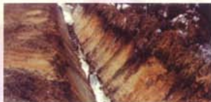
En creusant le fossé en forme de « V », l'écoulement de l'eau est facilité et les risques d'érosion sont peu élevés. Source: SPBM
