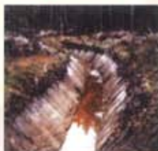
Pour minimiser l'érosion du fossé de drainage, le changement de direction est arrondi. Source: MRN
